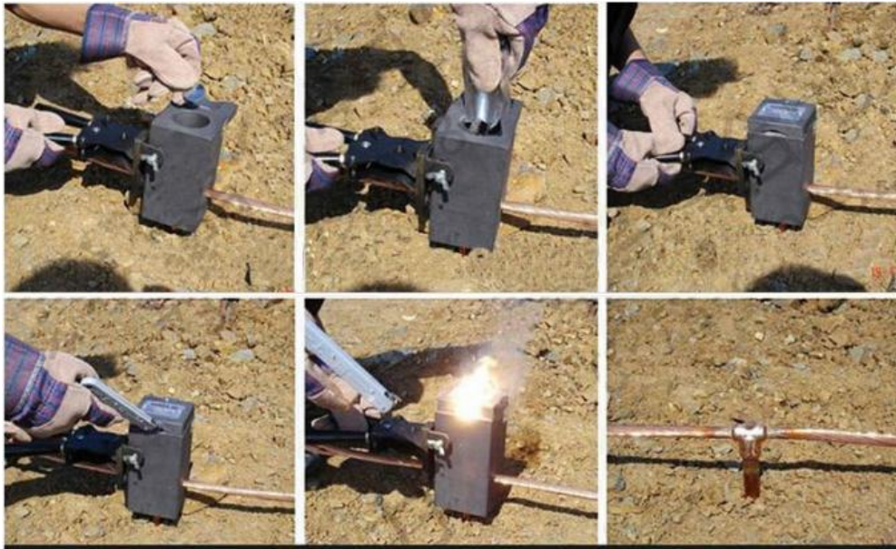
شکل ۳-۴- تجهیزات مورد استفاده برای انجام جوش اگزوترمیک
